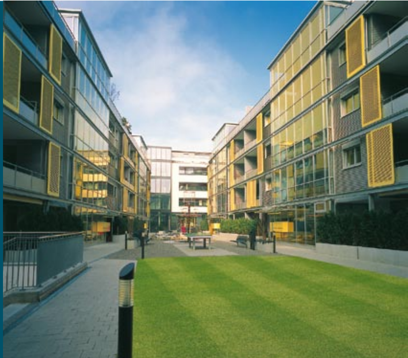
Superstructure habitable Akazienhof, Zurich, Suisse.
