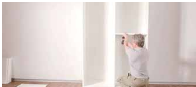
Conseil : - Placer la tablette d'un côté dans les trous entre axe 32 et fixer l'autre côté. - Le montage est plus facile avec des vis à tête fraisée.
