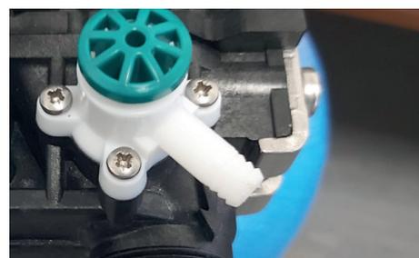
**15** Prendre un échantillon d'eau au niveau de la vanne test de sortie (appuyez sur le bouton vert pour faire couler l'eau).
