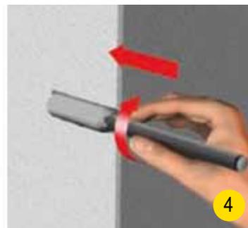
4. Introduire la tige filetée ou la douille en exerçant une légère rotation. Respecter le temps de mise en charge, positionner la pièce à fixer.
