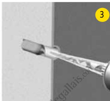
3. Glisser la poche souple dans le pistolet, introduire l'embase de l'embout dans le tube, visser la bague de verrouillage. Extruder la résine jusqu'à l'obtention d'une couleur uniforme. Introduire le mélangeur jusqu'au fond du trou puis injecter la résine.
