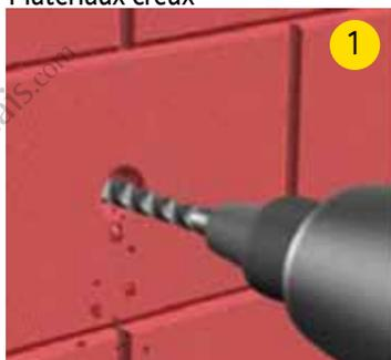
1. Percer un trou de diamètre et profondeur adéquats pour l'installation du tamis d'injection.
